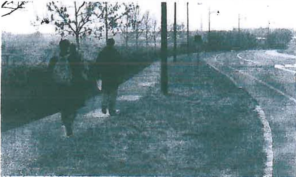
A Aulnoye-Aymeries, derrière le lycée Pierre et Marie Curie, la chaussée et les fossés qui ont été aménagés lors de la construction permettent de ralentir l'eau pluviale et ainsi éviter que celle-ci se déverse dans le réseau urbain.
