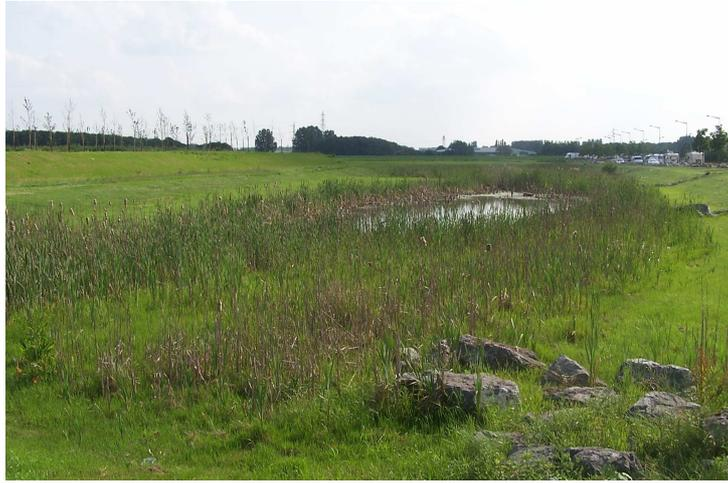
Photographie n° 10 : *Réservoir d'orage favorisant la biodiversité sur le site du parc de la Haute Borne à Villeneuve-d'Ascq*
