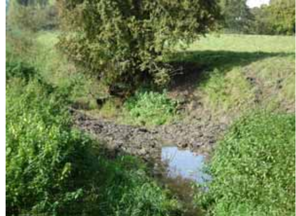
Piétinement des berges à l'exutoire du busage sous la RN2 sur le lit d'origine de l'Helpe Mineure (Etrœungt, le 04/10/2007)
