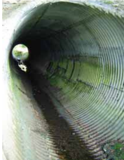
Busage sous la RN2 du lit d'origine de l'Helpe Mineure (Etroeungt, le 04/10/2007)
