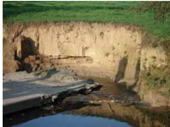
Erosion des berges au niveau de ce débitmètre (04/10/2007)
