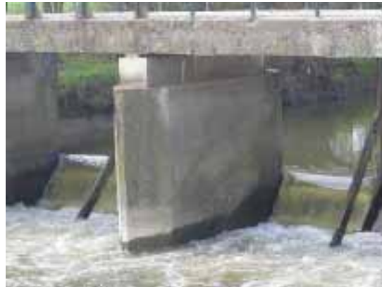
Barrage du Pont du Parc, Noyelles-sur-Sambre (19/04/2006)
